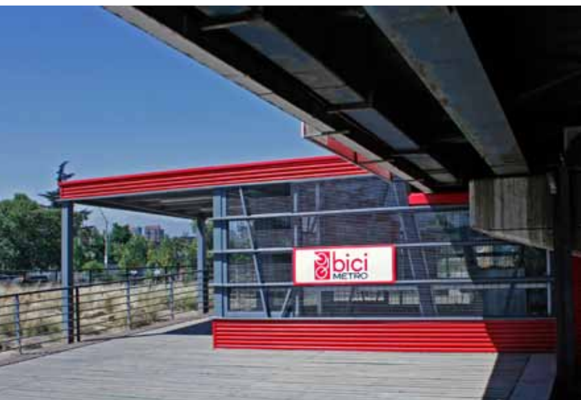
Foto 12: Guarderías para bicicleta en Metro, Estación Escuela Militar. Un avance que debe continuar.
